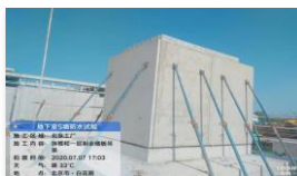
地下室防水试验
