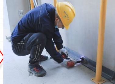
底部封堵模具 拆除
