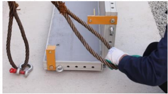
外侧模具吊装
