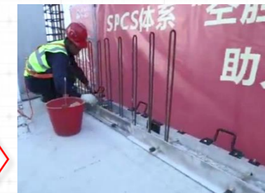
底部封堵模具 组装、摆放
