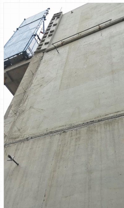
拆模后成型面
