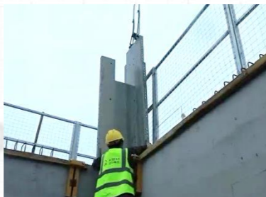
后浇节点 外侧模具吊装
