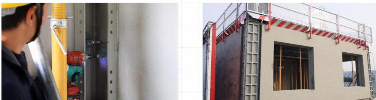
对拉螺杆拆除
