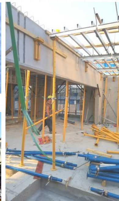
独立支撑安装
