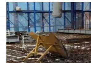
混凝土卸料斗
