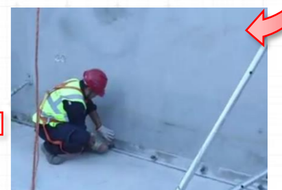
底部封堵模具 紧固
