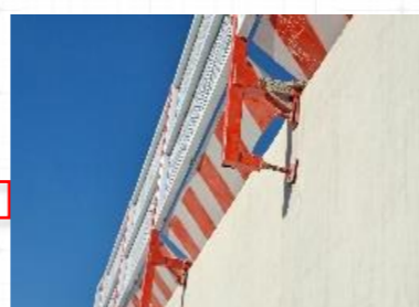
临边防护 安装
