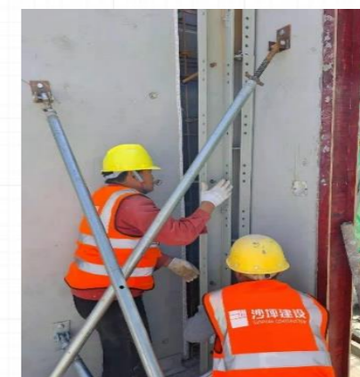
内侧模具安装
