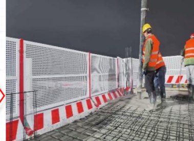
混凝土浇筑
