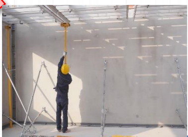
水平工业化支撑安装
