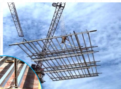
背框整体吊装
