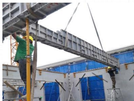
梁模整体吊装
