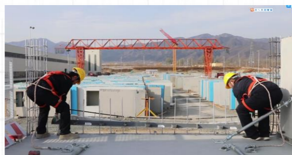
底部封堵工装就位
