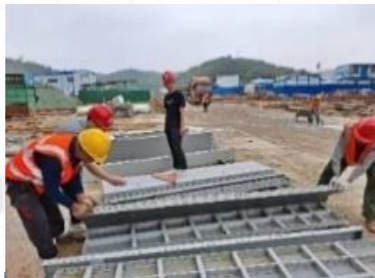
后浇节点 模具倒运、组装
