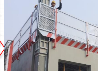
后浇节点模具 拆除
