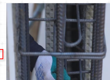
水平环筋 安装
