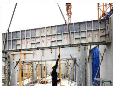
独立支撑安装
