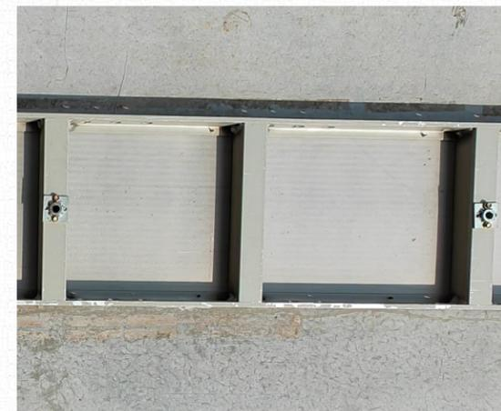
外侧模板提前安装螺纹固定件
