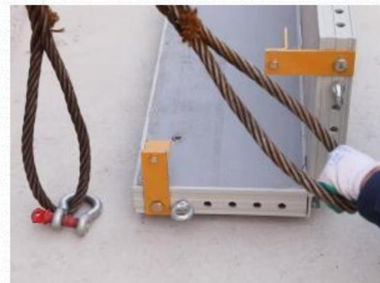
安装好吊环，墙板上部定位挂钩
