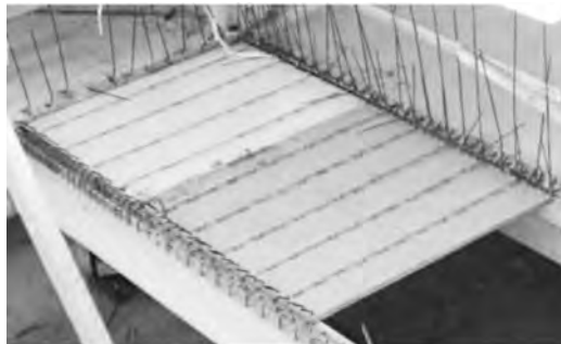
图 5-29 预制叠合板安装
