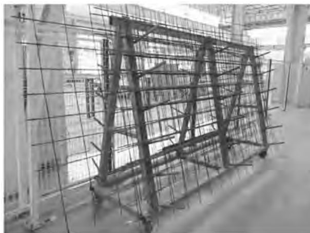
图 4-64 焊接成型的钢筋网片
