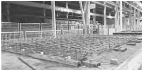
图 4-22 钢筋与预埋件安装
