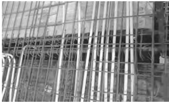
图 5-30 机电管线铺设
