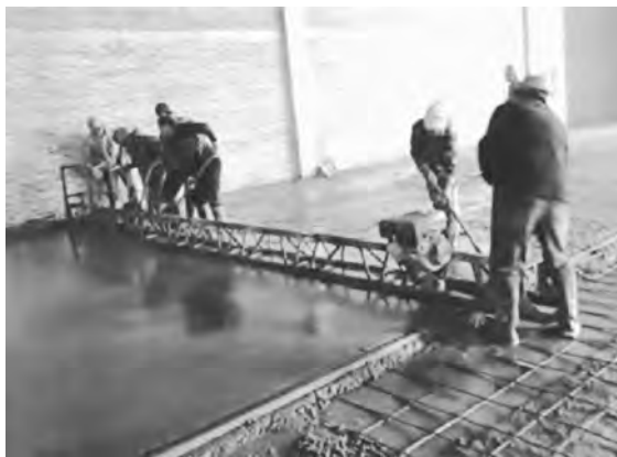
图 4-17 混凝土振捣
