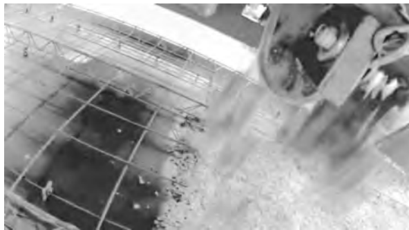
图 4-23 混凝土布料
