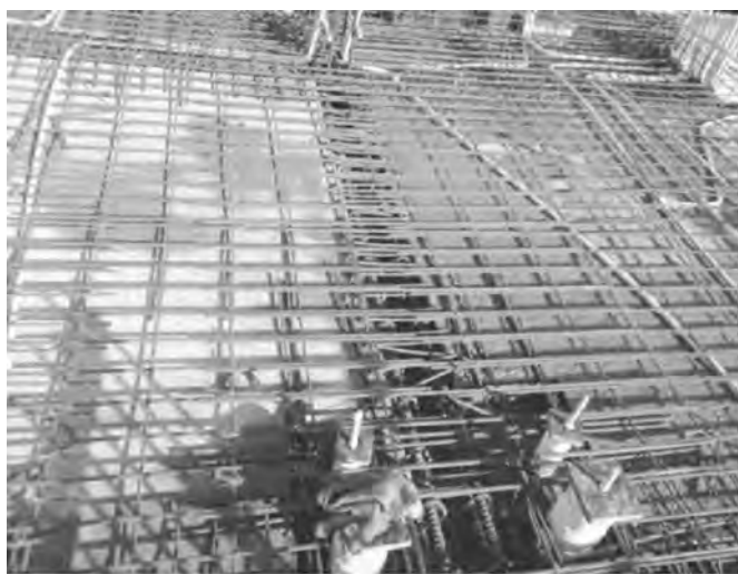
图 4-59 楼板预制成型钢筋网片
