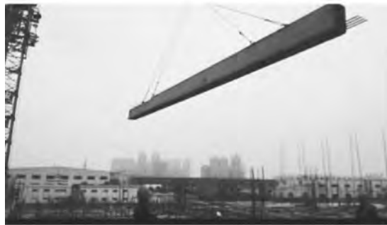
图 5-28 预制梁安装
