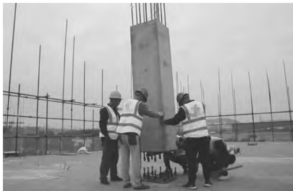
图 5-22 预制空腔柱吊装
