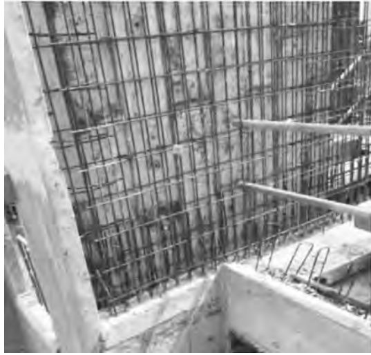
图 4-60 剪力墙预制成型钢筋网片
