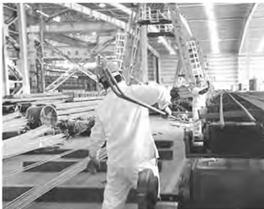
图 4-11 人工钢筋加工
