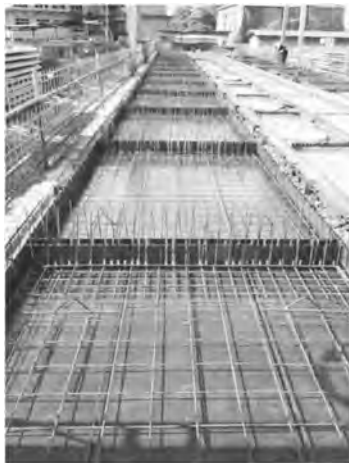
图 4-8 预应力叠合楼板长线模台
