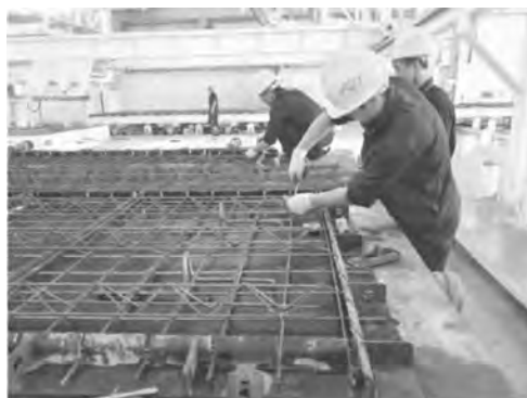
图4-13 工人钢筋安装
