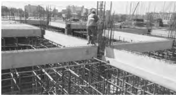
图 2-4 混凝土叠合梁施工
