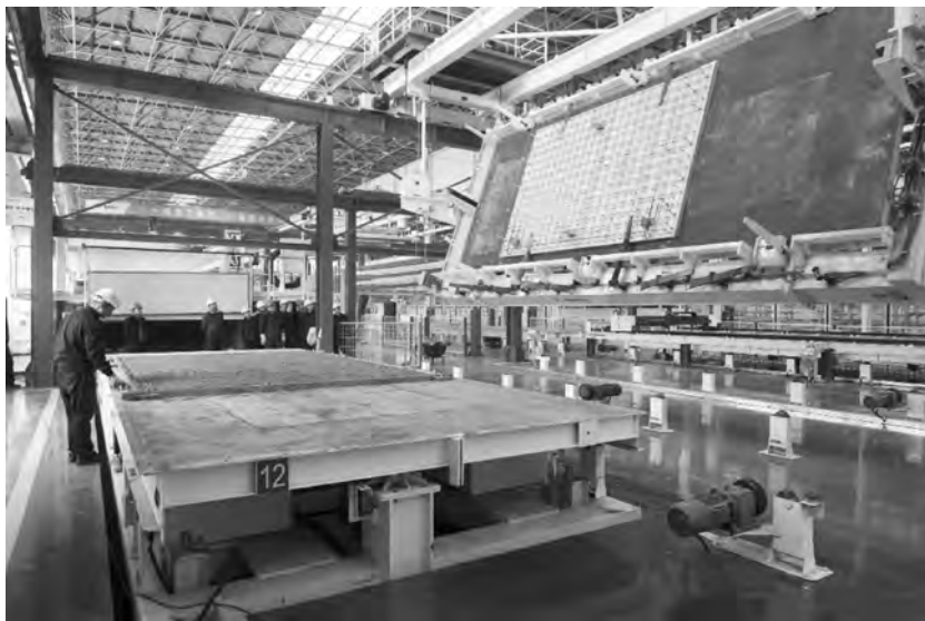
图 2-10 第一面墙板翻转
