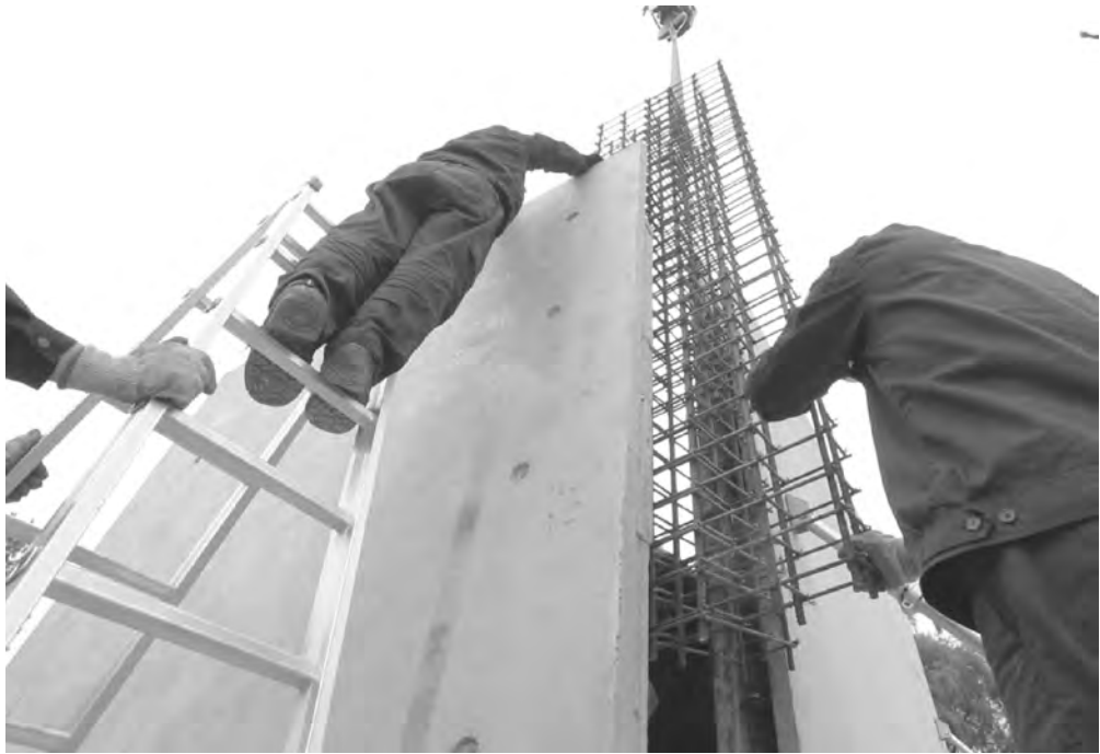
图 2-15 成型钢筋笼在墙体连接现浇段的现场安装
