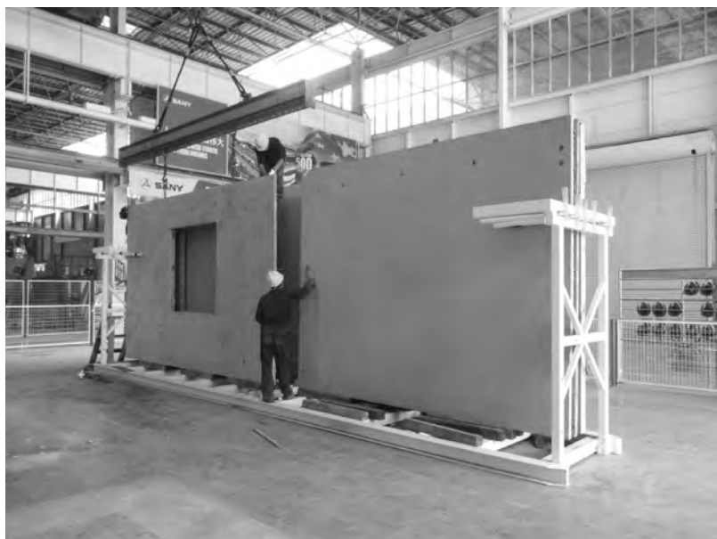
图 2-12 叠合墙构件下线
