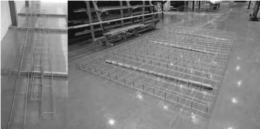
图 2-4 工厂自动焊接的钢筋网片和组装完成的墙体用钢筋笼
