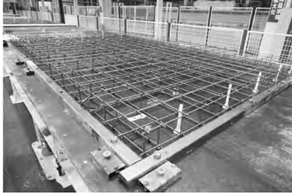
图 2-6 钢筋与预埋件安装
