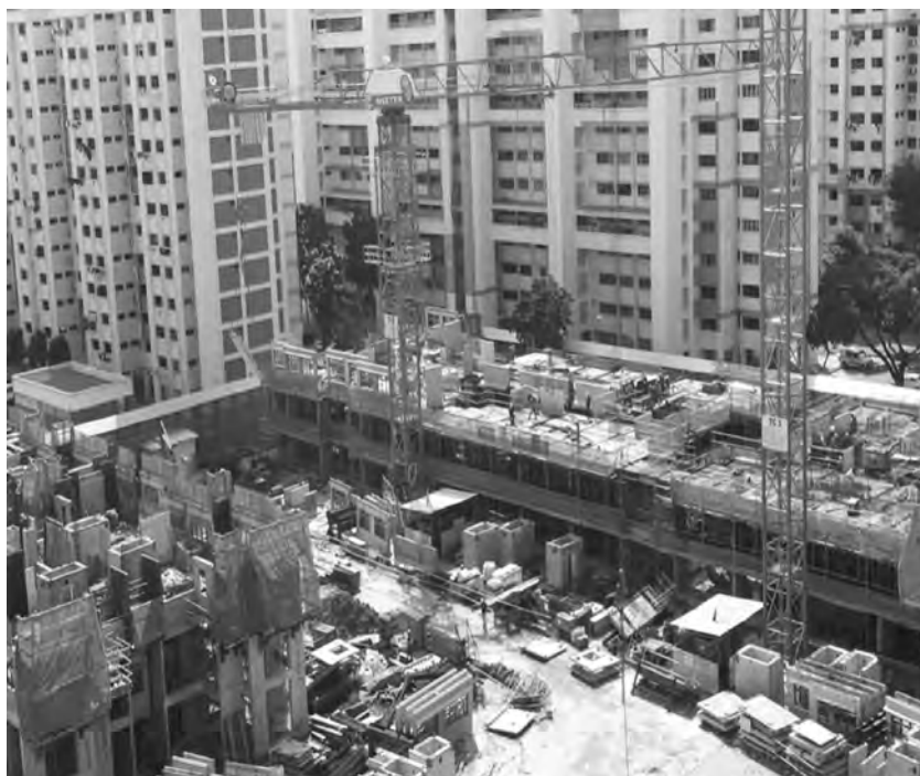
图 2-13 装配式建筑施工现场总览
