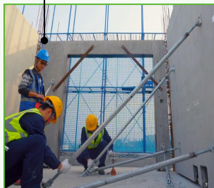
空腔墙支撑安装
