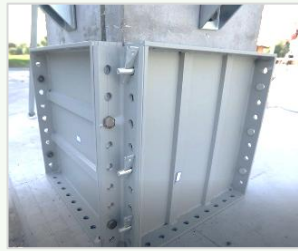
➤ 模板:现浇区模板安装
