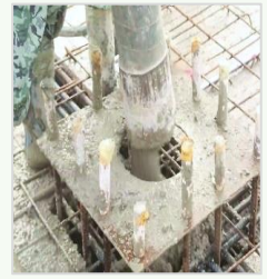
➤ 浇筑:钢筋固定、浇筑
