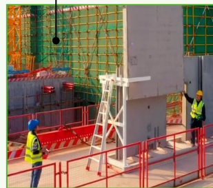
空腔墙支撑安装
