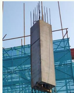
➤ 起吊:构件起吊转运
