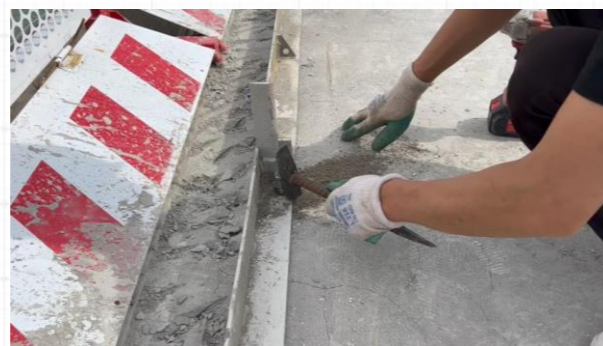
钻孔及胀栓安装
