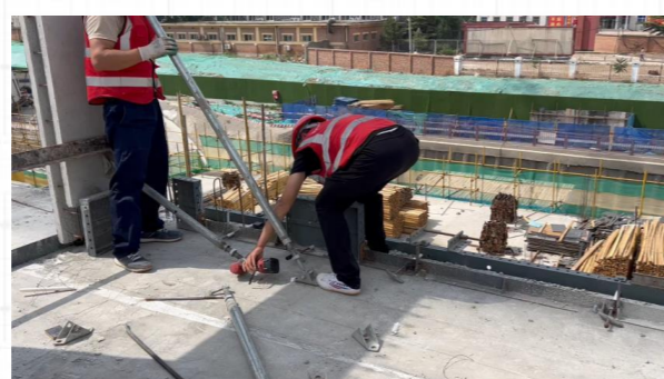
对拉螺杆安装
