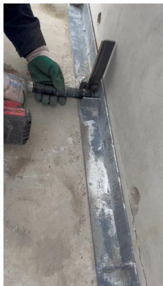
底部封堵工装紧固
