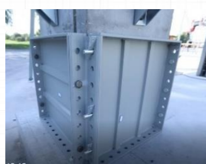
柱底模具安装
