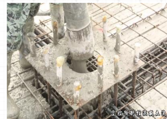
混凝土浇筑
