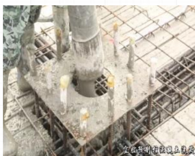
混凝土浇筑
