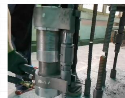
四角冷挤压连接
