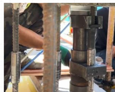
边筋套筒连接
