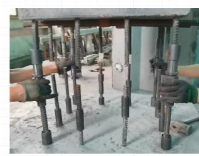
四角钢筋对位
