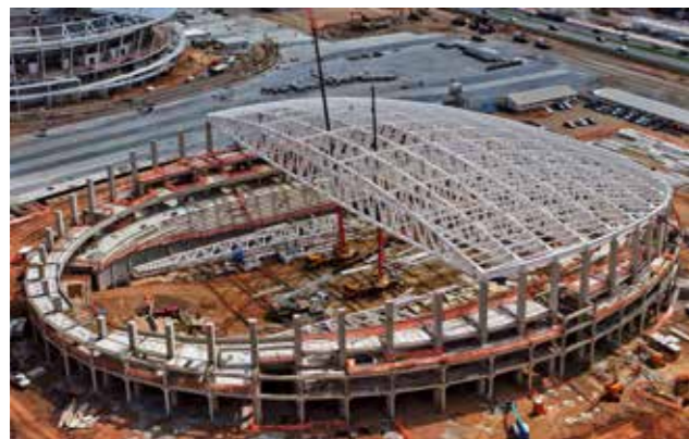
巴西 奥运场馆建设
