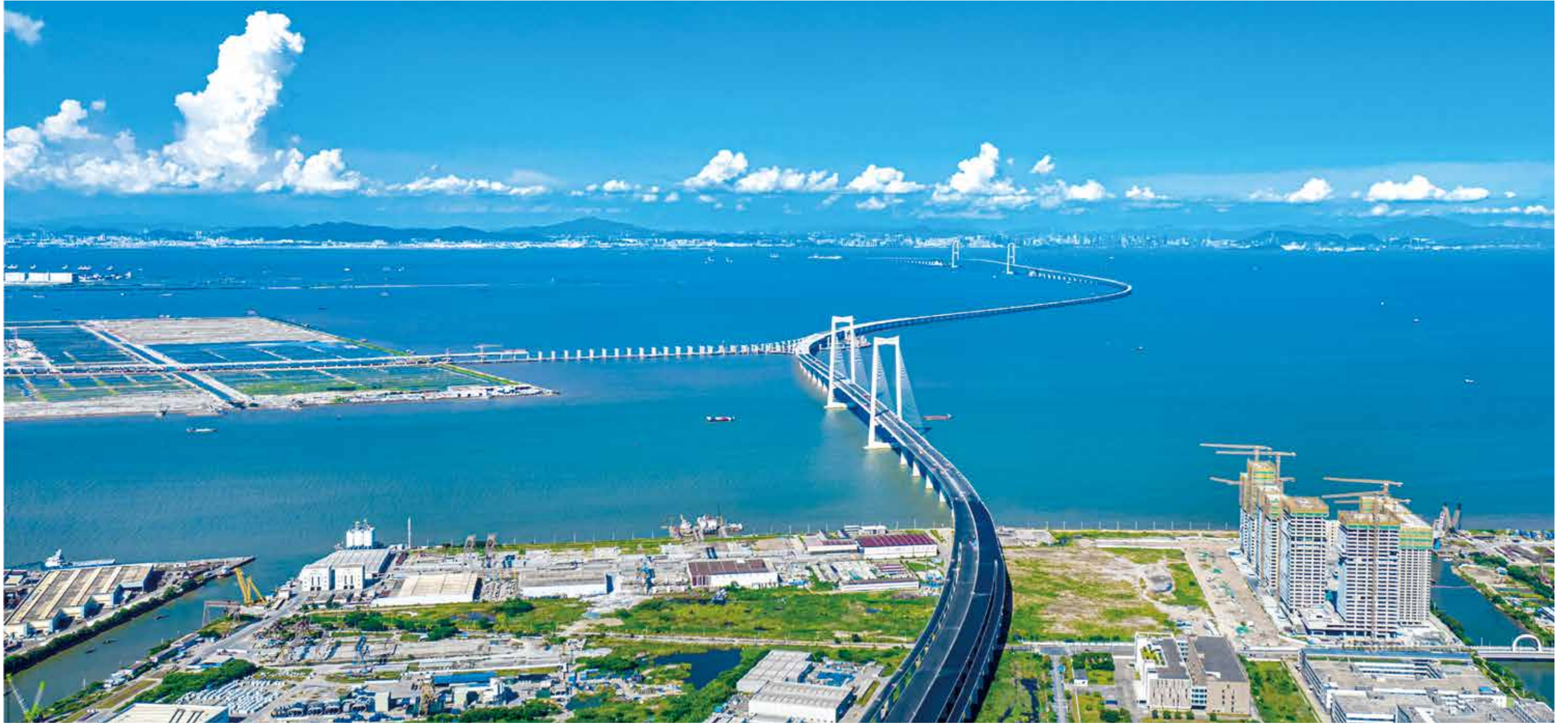
广东 深中通道伶仃洋大桥
